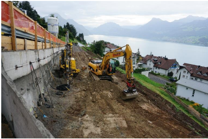
Aushubarbeiten am Hang
