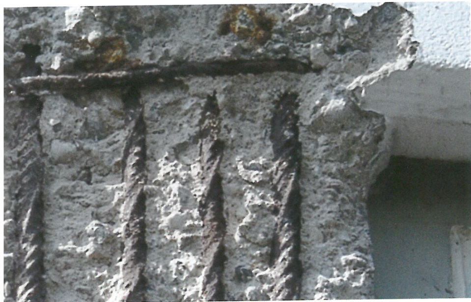
Im Schweizer Hochbau wurden 2011 rund 21 Mrd. CHF verbaut. Davon mussten 1,6 Mrd. CHF in die Mängelbehebung investiert werden.
