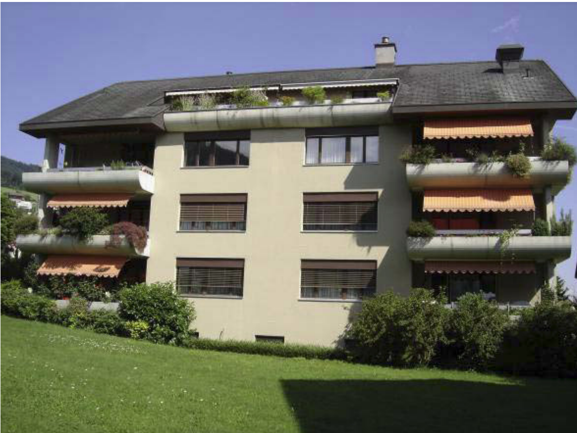
Mattli in Hergiswil (vor Sanierung)
