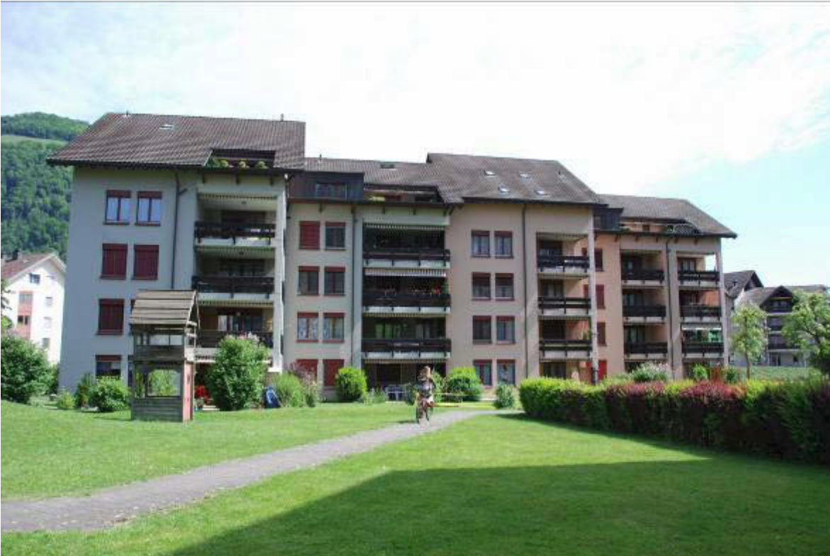
Aemättlihof in Stans (vor Sanierung)
